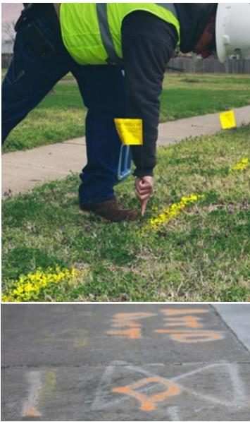
Cuando se planifica un proyecto de construcción para un área específica, los localizadores de líneas marcan las instalaciones subterráneas para que los excavadores sepan que no deben excavar cerca de las marcas. Si bien puede parecer un lio de líneas, el "graffiti de utilidad" es una precaución de seguridad muy importante; y a diferencia de otros graffitis, estas marcas de servicios públicos se desvanecerán después de algunas semanas.
